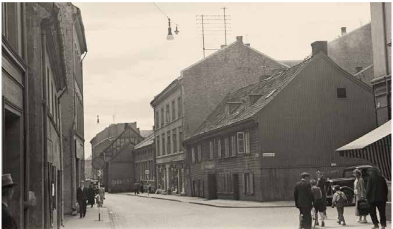
Lakkegata 20 er huset i 2 etasjer med åpent vindu. Juni 1938. Ukjent fotograf. Eier Oslo Museum.
